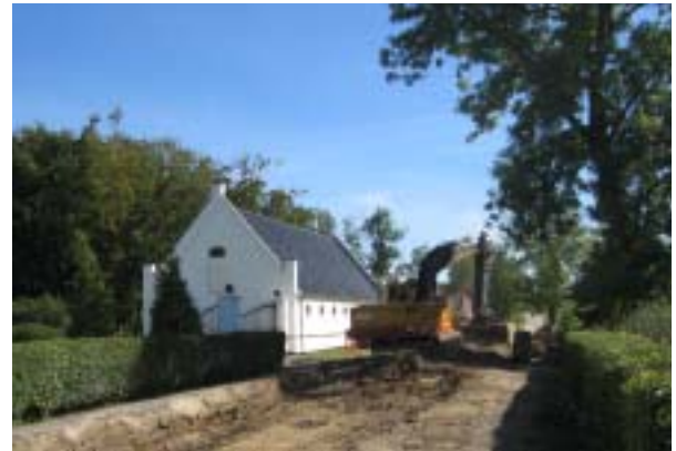
Bygning syd for godsets hovedbygning
